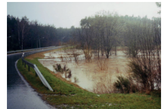
Regenrückhaltebecken nördlich von Kemnath
